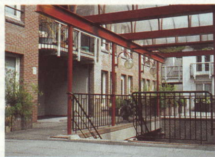
De woningen in het Entrepotdok zijn gegroepeerd rond binnenhoven.
